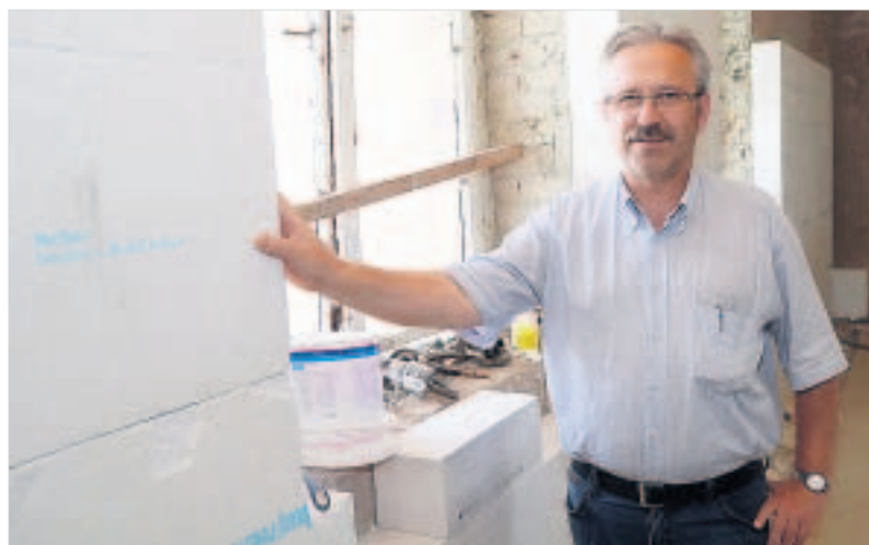
Bauherr Frank Weser erläutert die seltene Innendämmung. Sie besteht aus Knauf-Perlite, einem mineralischen Naturprodukt aus Spanien. Fotos: Brühl (2)
